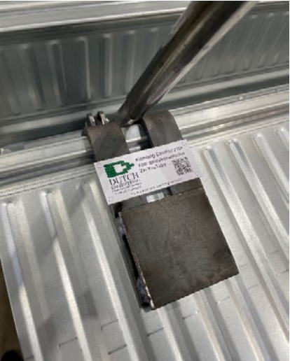
Zijoverlap - klemmen met Klemtool h.o.h. 1500 mm | Daarna schroeven met parkers h.o.h. 350 mm
