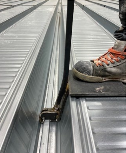
Zijoverlap - klemmen met Klemtool h.o.h. 1500 mm | Daarna schroeven met parkers h.o.h. 350 mm
