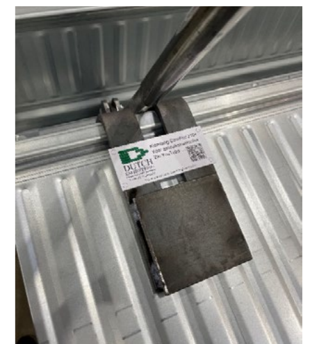
Zijoverlap - klemmen met Klemtool h.o.h. 1500 mm | Daarna schroeven met parkers h.o.h. 350 mm
