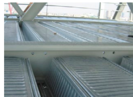
Doorvoeren koppelwapening bij uitvoering volgens Detail 2.
